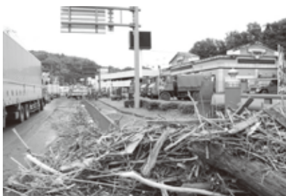
◆被害の跡が残る竹田市の様子 (被災当時)
